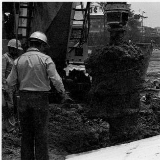
La cimentación del edificio Galerías "Melchor Ocampo" se resolvió mediante pilas y pilotes desplantados a 27.30 m de profundidad. En la composición se aprecian tres fases de los trabajos.
